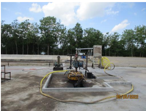
รูปที่ 2-10 คันคอนกรีตล้อมรอบหัวหลุมผลิต
