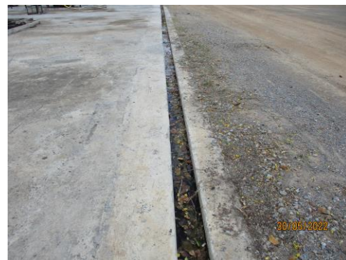
รูปที่ 2-20 รางระบายน้ำรอบฐานเจาะคอนกรีต
