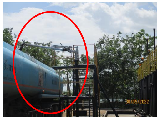
รูปที่ 2-9 ระบบการขนถ่ายน้ำมันจากถังกักเก็บ แบบ Swing Type
