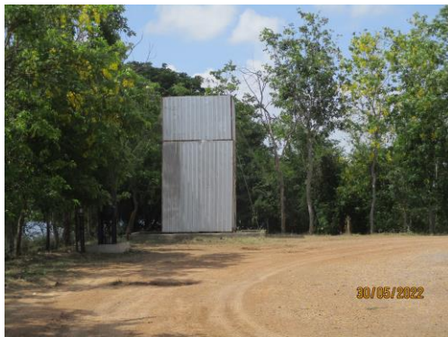
รูปที่ 2-8 กำแพงสังกะสีล้อมรอบปต่องเผาก๊าซ
