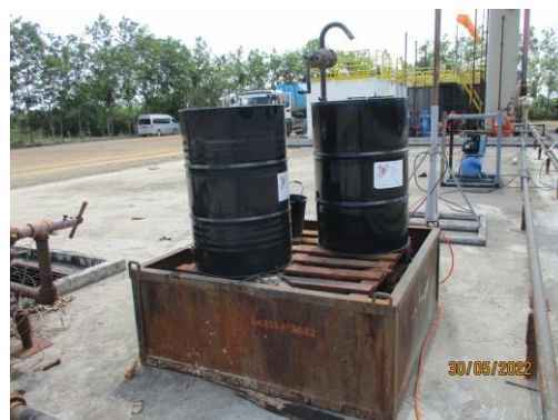
รูปที่ 2-13 การจัดวางสารเคมีบนถาดรอง
