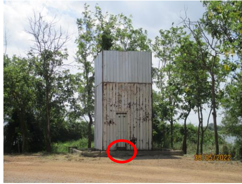
รูปที่ 2-7 ปต่องเผาก๊าซมีความสูงไม่เกิน 4 เมตร
