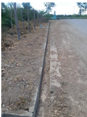
รูปที่ 2-12 รางระบายน้ำโดยรอบฐานหลุมผลิต
